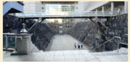
ドックヤードガーデン(旧第2号船渠)
