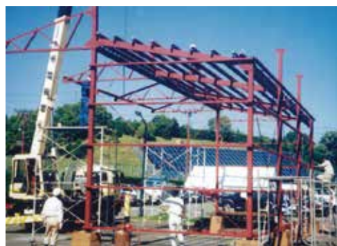
鉄骨組立(ドラマセット)
