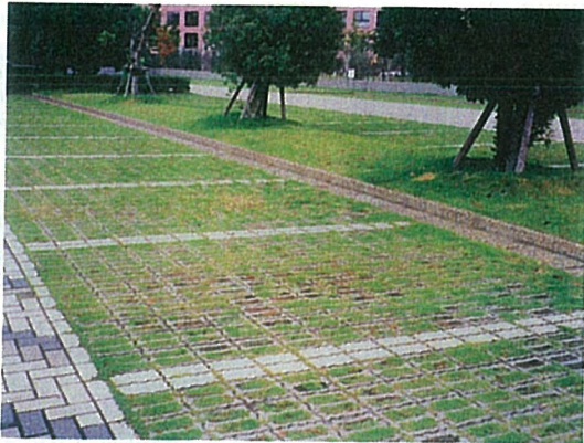
駐車区画を緑化ブロックや中木、ブロック舗装で修景している例(浦安氏)
