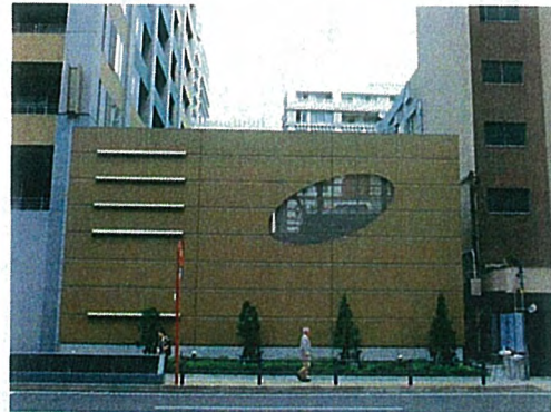
通りの連続性に配慮して立体駐車場外壁をデザインした例（関内地区）
