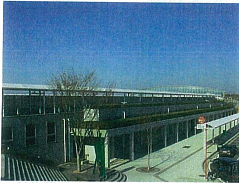
屋上緑化された駐輪場(石岡市)
