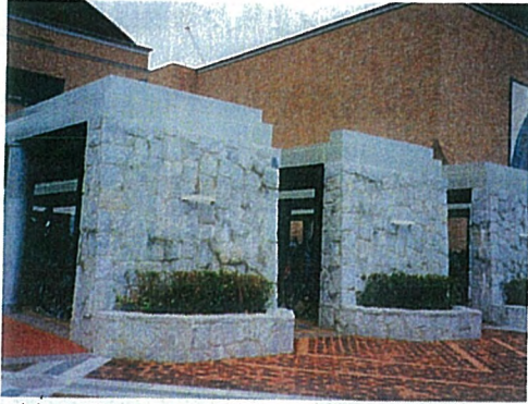
建物と調和した工作物によって駐輪場を隠している例
