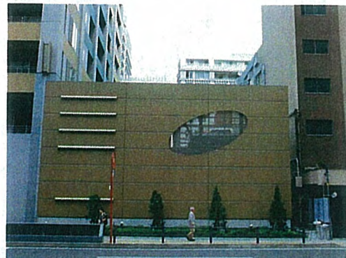
通りの連続性に配慮して立体駐車場外壁をデザインした例（関内地区）
