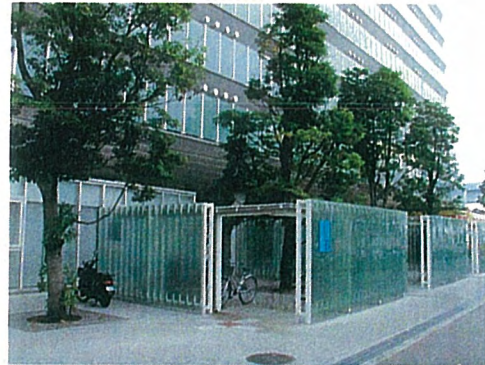
緑と半透過性素材によって軽快に仕上げている駐輪場(渋谷区)
