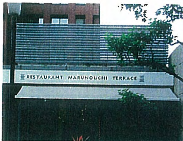
積極的に外壁デザインと合わせたルーバー(千代田区)
