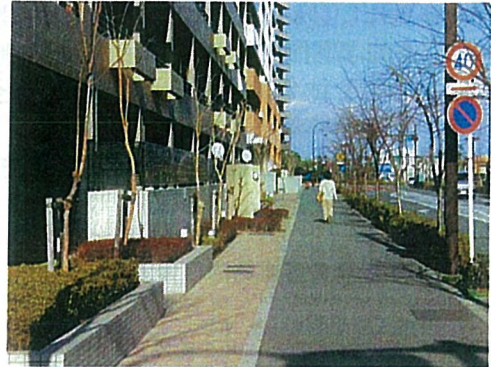
1階を駐輪場として、修景壁で隠している例(横須賀市)
