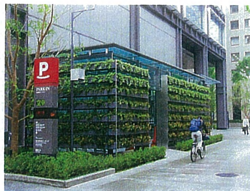
壁面緑化された駐輪場（千代田区）
