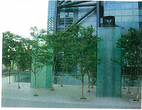
吸排気等を建物外壁と同様なガラスで修景した例(港区)
