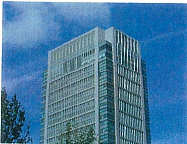
塔屋を建物と一体的にデザイン(横須賀市)
