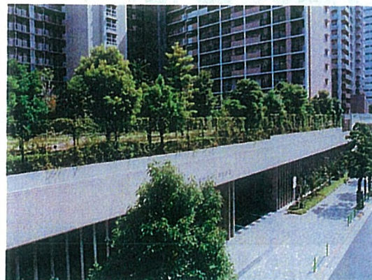
通りの連続性や緑の連続性をとぎれないように駐車場の出入口を設けた例(港区)
