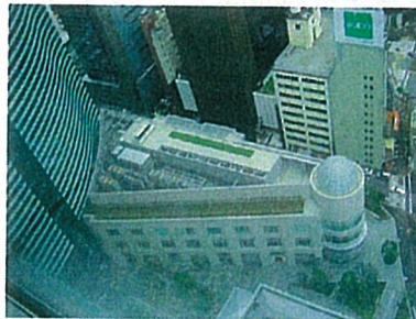
上方からの見え方にも配慮した設備類の修景(港区)
