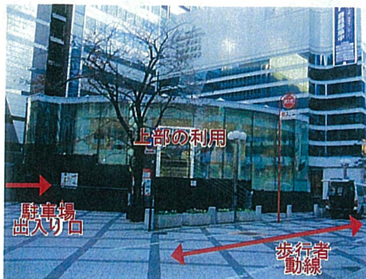
地下駐車場の出入口を歩行者のメイン動線を避けた配置としている例(千代田区)
