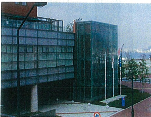
透過性素材によって軽快に仕上げつつ、美しく見せる外階段のデザイン(地区内)
