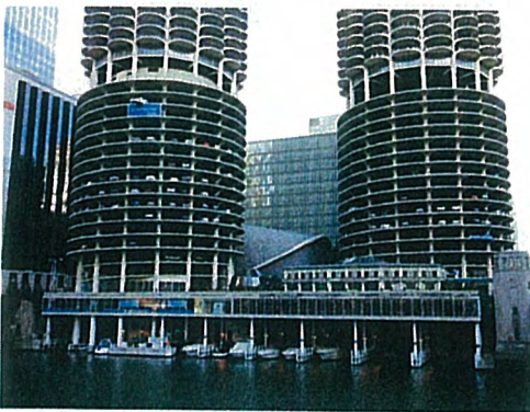
立体駐車場そのものを建物デザインに調和させた例（シカゴ）
