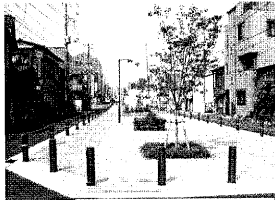
(地下化区間) 緑道供用区間
