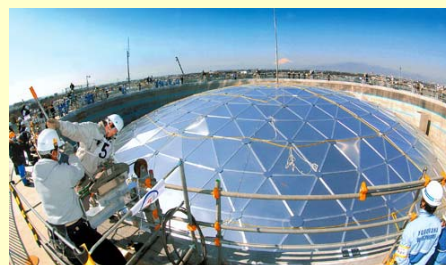
小雀6号配水池の施工状況
