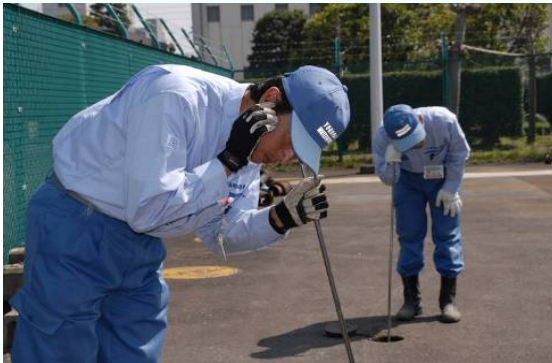
音聴棒による漏水音の捕捉技術の修得
