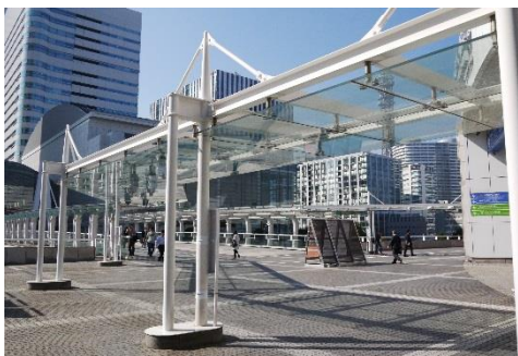
ペDESTリアンデッキの整備
