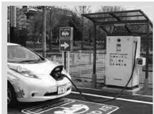
EV充電器の設置
