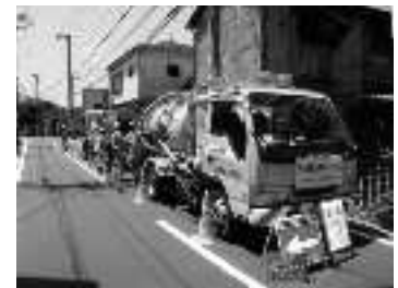
吸引車による下水道管の清掃
