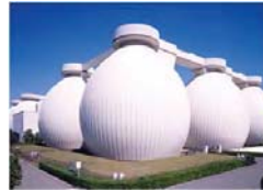
汚泥集約処理（卵形消化タンク）
