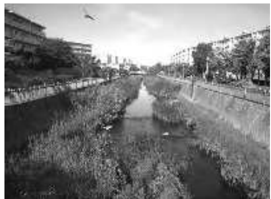
植生を施した多自然川づくり
