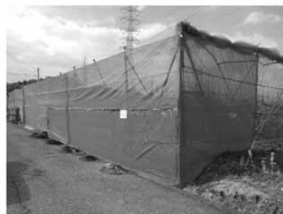
【写真】 農薬飛散防止ネットの設置事例
