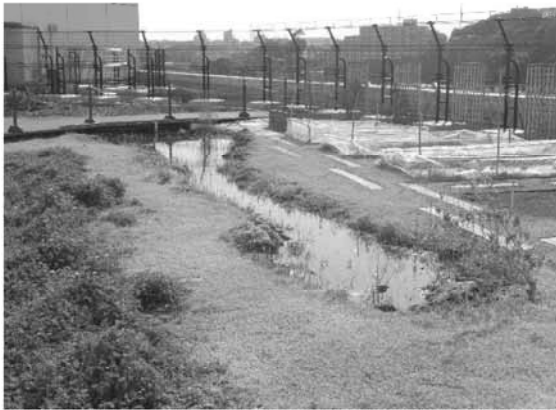
【写真】 戸塚区/戸塚区総合庁舎（屋上）
