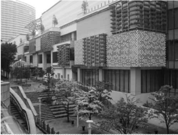
【写真】商業施設の壁面を緑化 （西区/みなとみらい21中央地区）
