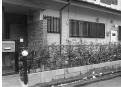
【写真】 生垣設置の事例（旭区）
