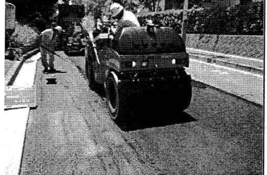
道路の維持・管理（舗装補修）
