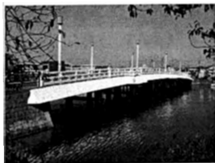
一般橋梁 (夕照橋：金沢区)
