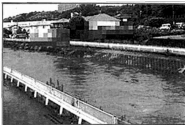
降雨時 (平成25年8月21日、都筑区)
