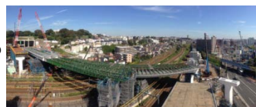
横浜環状北線 (生麦鉄道交差部)
