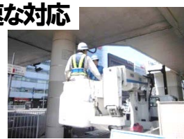
計画的な保全のための歩道橋点検
