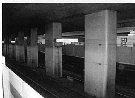
【中柱を補強した開削トンネル】
