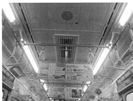
【LED化した地下鉄車両の照明】
