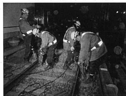
【軌道整備を行う地下鉄保守職員】
