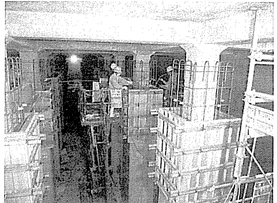
配水池耐震補強工事
