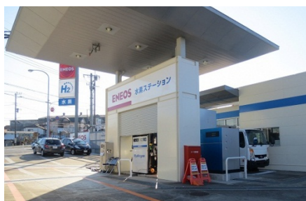
固定式水素ステーション（旭区）
