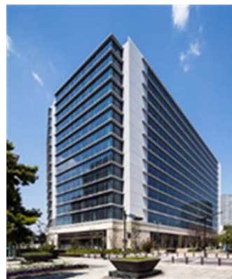
横浜アイマークプレイス LED 照明、太陽光発電、自然換気などの 環境配慮技術を導入
