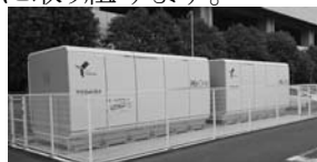
自立型水素燃料電池システム
