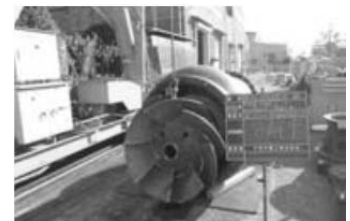
主ポンプ更新
