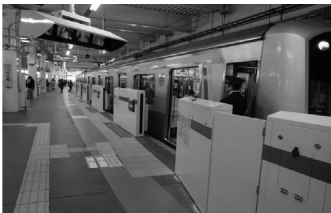
可動式ホーム柵の設置状況 (27年度整備：東急東横線菊名駅)
