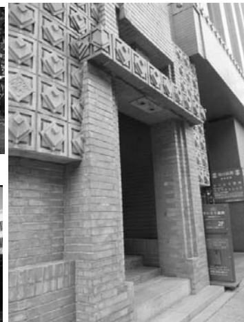
綜通横浜ビル
