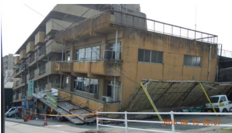
ピロティ崩壊の様子（熊本地震）
