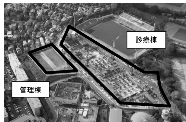
■ 建設工事の状況（平成30年11月時点）
