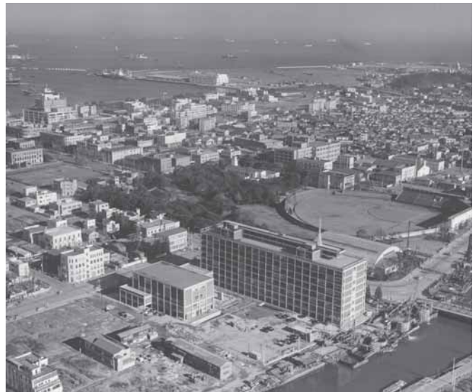
昭和34年竣工時
