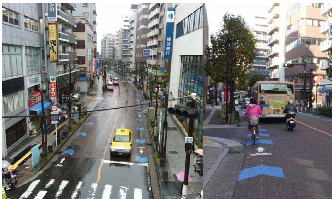
図 5-59 車道混在型（矢羽根）の設置
