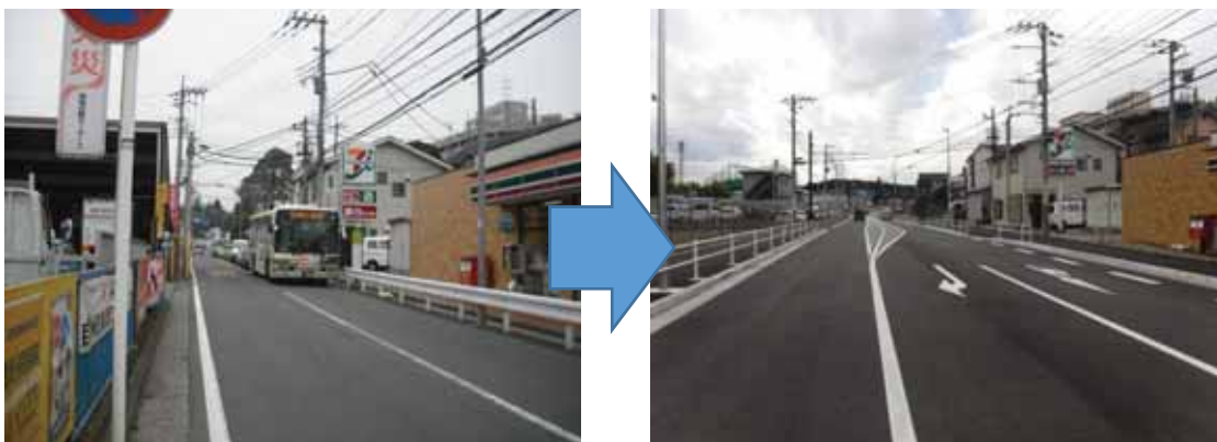
図 5-28 道路の拡幅整備（旭区）
