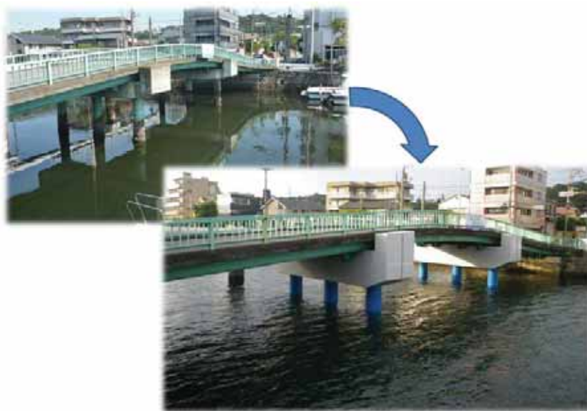
図 5-5 2 橋梁の耐震化（磯子橋）
