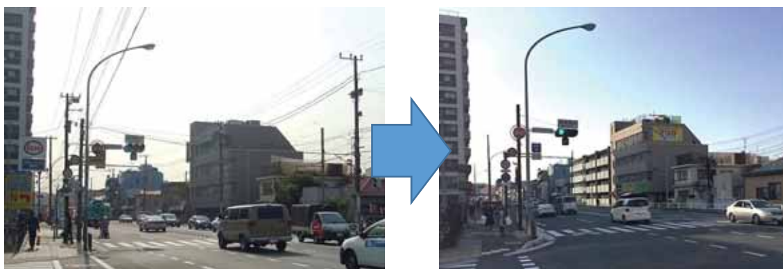
図 5-5 3 緊急輸送路の無電柱化（磯子区）
