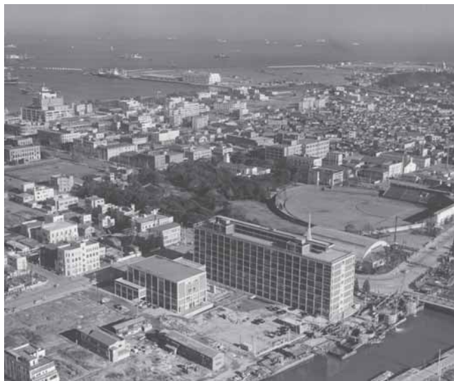
昭和34年竣工時
