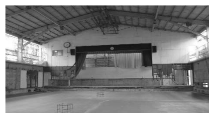
小学校体育館の改修工事
