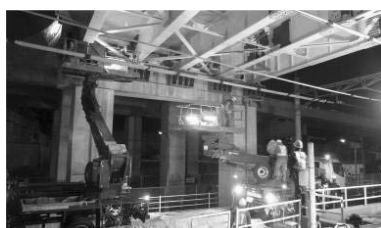
橋りょうの保全工事
