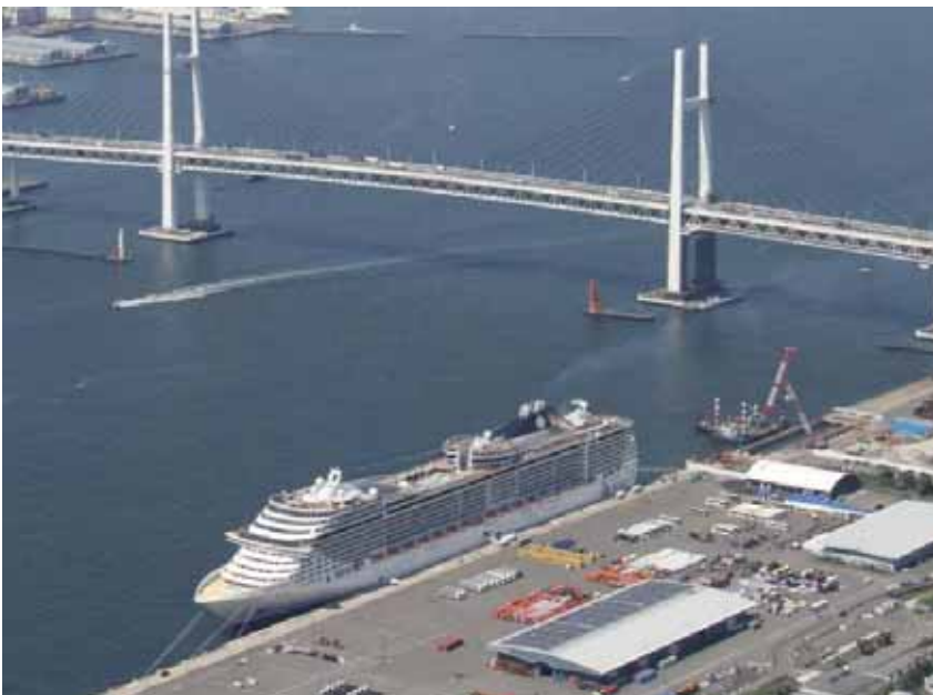
大黒ふ頭への大型客船寄港の様子
