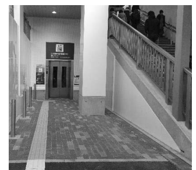
西口エレベーターおよび西口階段（新設）
