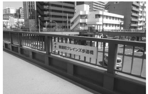
鶴屋町クレインズ歩道橋
