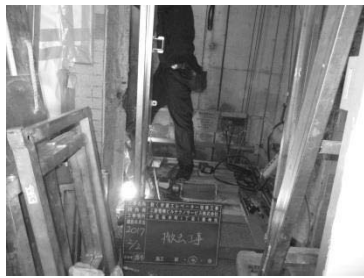
エレベーター撤去工事
