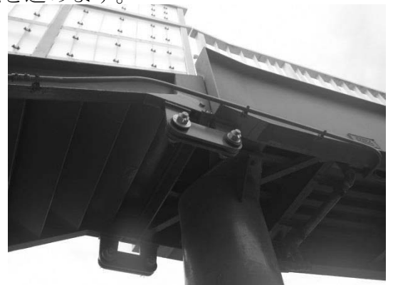
落橋防止装置：西町歩道橋（磯子区）
