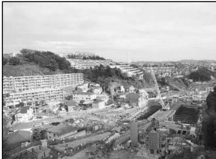
②公田地区掘割試験工事 （栄区公田町） 平成29年11月
