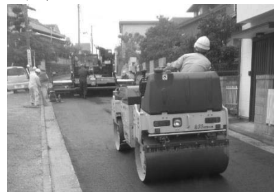
舗装修繕工事の状況
