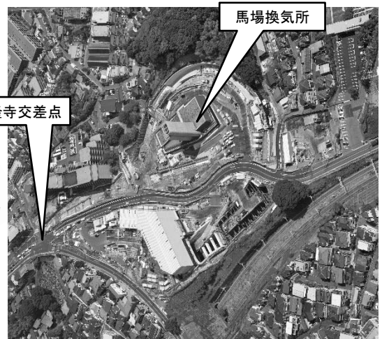
工事実施状況（平成29年6月）
