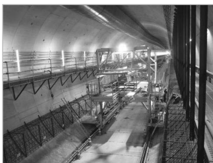
シールドトンネル坑内 （平成30年3月）
