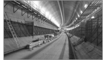
整備中の横浜環状北西線
