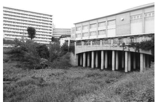
野庭団地第一雨水調整池
