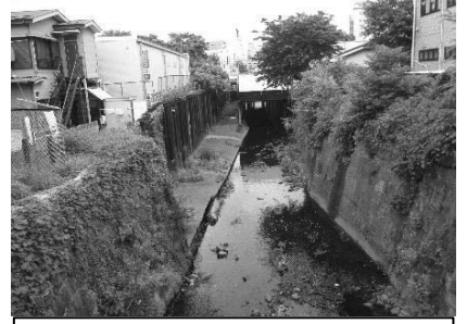
護岸改修 (今井川：保土ヶ谷区岩井町)
