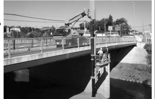
近接目視点検：都橋(緑区)
