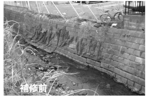
水路護岸補修(戸塚区平戸町)
