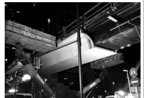
化粧パネルの撤去：けやき通り歩道橋(西区)
