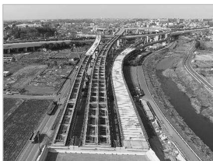
橋りょう工事（青葉区下谷本町） （平成30年3月）
