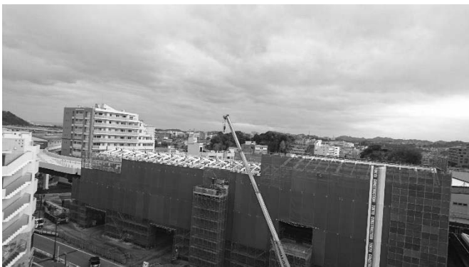
橋梁工事が完了し新駅舎の建築工事が本格化(平成30年3月)
