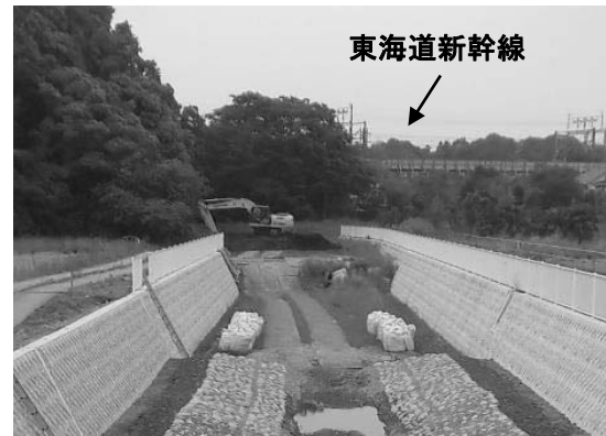
新幹線下の護岸改修 (和泉川：泉区和泉町)
