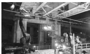
橋梁の保全工事
