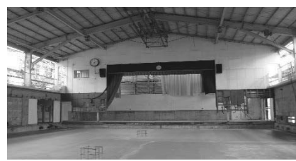
小学校体育館の改修工事
