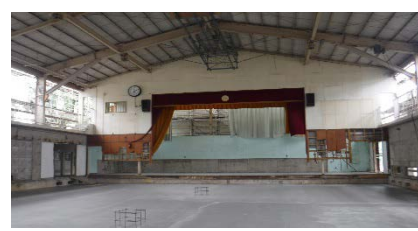
小学校体育館の改修工事
