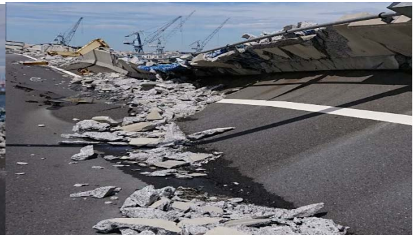
【はま道路橋梁の表面②】
