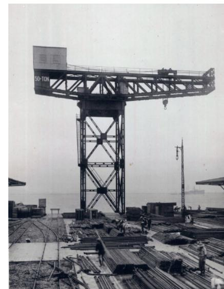
金づちに似た形状からハンマーヘッドクレーンと呼ばれた日本で最初の湾港荷役専用クレーン
