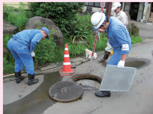
新潟県中越沖地震 調査時の様子
