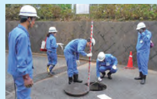
下水道管実地調査訓練
