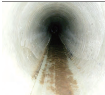
更生後の下水道管
