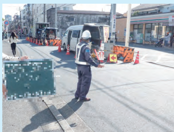
施工状況(形成工法)
