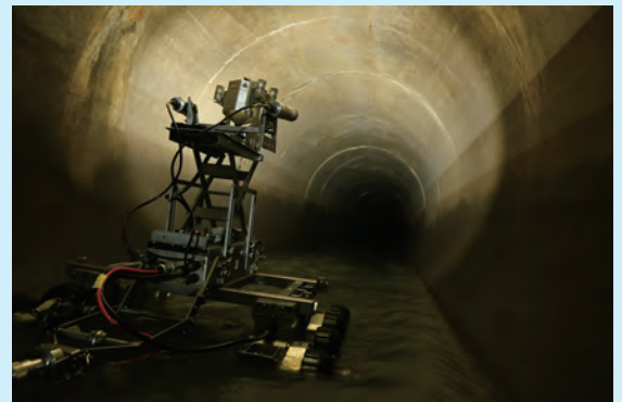
中大口径管の調査状況
