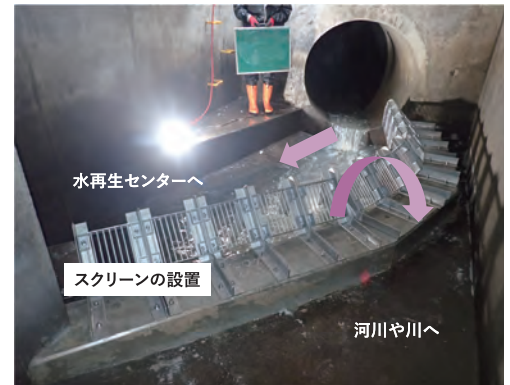
雨水吐の改良状況
