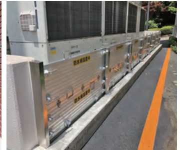
機械設備の耐水化（止水板）
