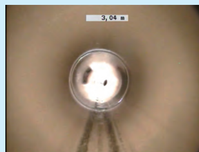
ノズルカメラでの下水道管内撮影画像
