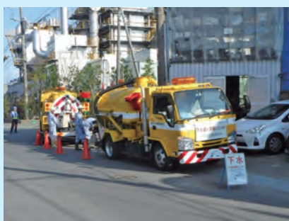
吸引車による下水道管の清掃
