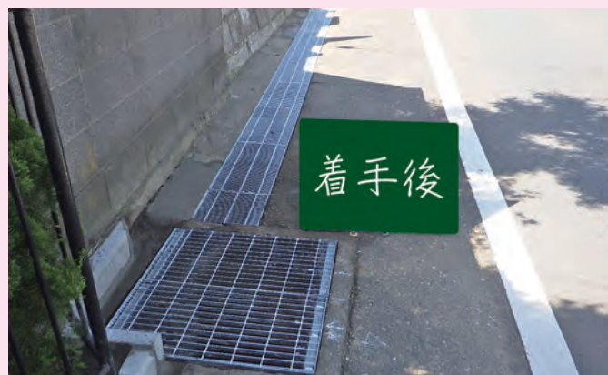
既存コンクリート蓋をグレーチング化した事例 着手前(左) 着手後(右)
