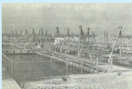
稼働当時の反応タンク・スイングデフューザ
