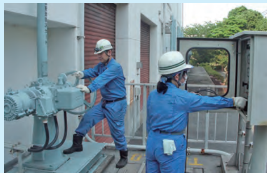
主要設備の点検 ゲート設備
