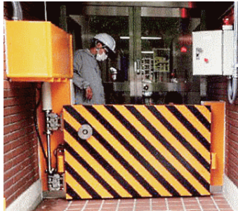
建物の耐水化（防水扉）
