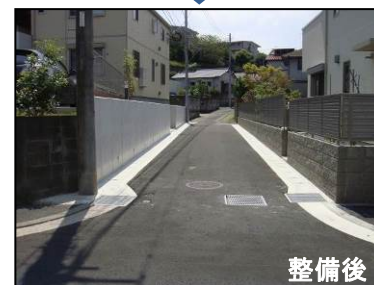
狭あい道路拡幅整備工事
