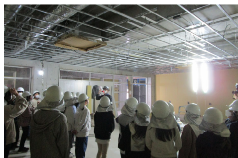
【都岡小学校建替え工事における出前授業】
