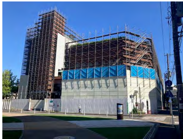
②ホテルメルパルク横浜 (令和5年12月閉館・解体工事中)
