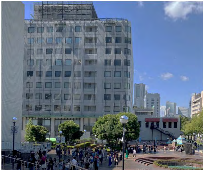
①老朽化した施設の更新
