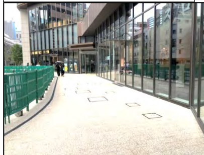
タクシー乗車場周辺の歩行者空間整備
