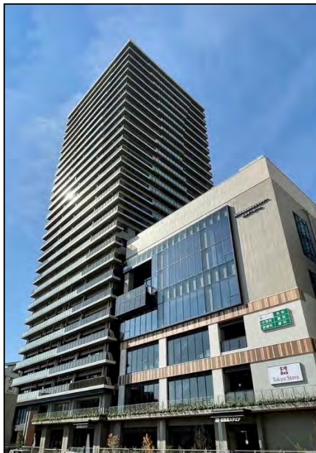
新綱島駅前地区（港北区） 【令和5年度完了】
