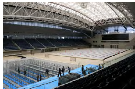
床転換工事の様子
