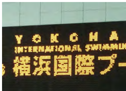
大型ビジョンの球切れの状況
