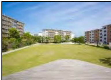
②北団地広場改修：芝生広場等、明るく風通しのよい空間を整備 (令和2年10月)
