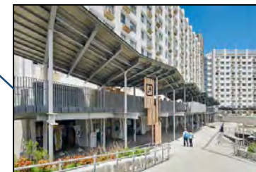
⑦中央団地広場改修 (平成30年度改修)
