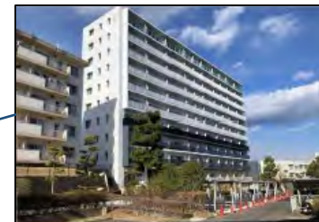
④北団地 1-11号棟 (令和3年3月竣工)
