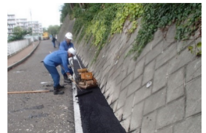
<道路の補修作業>
