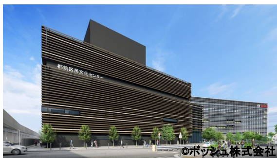
《センター北駅側から区民文化センターを見た様子》
