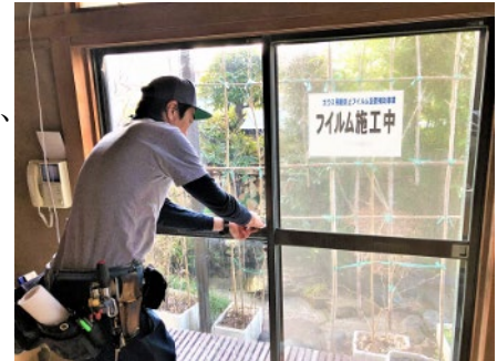
窓ガラス飛散防止フィルム施工作業
