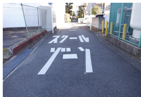
通学路 路面標示の補修
