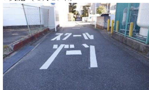
通学路 路面標示の補修
