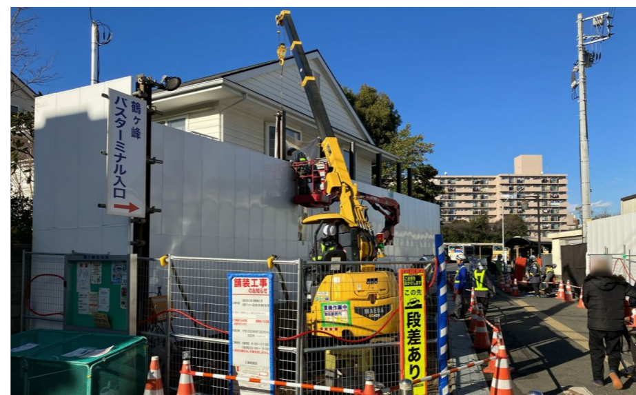
鶴ヶ峰バスターミナル改変工事が始まりました
