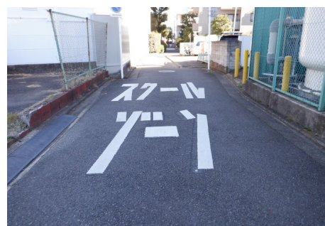
通学路 路面標示の補修
