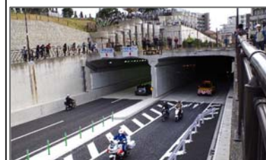
柏尾戸塚線（とつか地下道）
