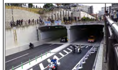
柏尾戸塚線（とつか地下道）
