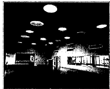
第三体育室をLED照明に更新
