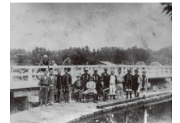
昭和2年(1927年) 高嶋橋の架け替え工事 横浜新道の建設(昭和30年代)なども…
