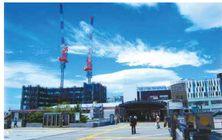
戸塚駅東口ペDESTリアンデッキから望む建設中の区役所(左)とトッカーナ(右) (平成24年(2012年)) / 提供: 中野泰雄さん
