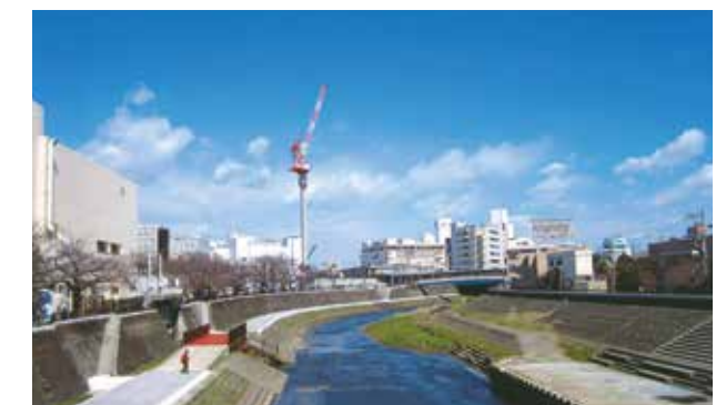
柏尾川から望む建設中の区役所(平成24年(2012年)) 提供:中野泰雄さん
