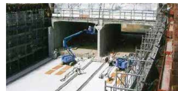
工事中のアンダーパス東側(平成21年(2009年)) 出典:戸塚駅前地区中央土地区画整理事業事業誌
