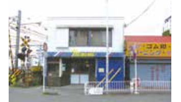
解体前(平成27年(2015年))
