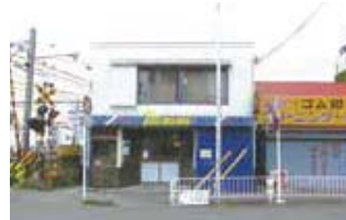
解体前(平成27年(2015年))
