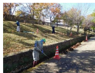
排水溝の清掃
