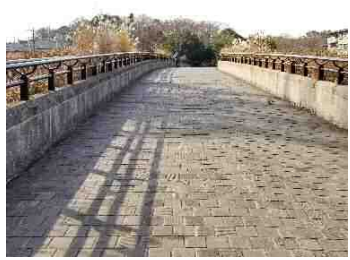
両脇に植栽帯を備えた公園橋
