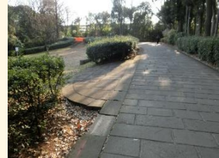
整備前の白河石舗装
