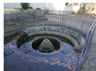
雨水管への流入部とスクリーン
