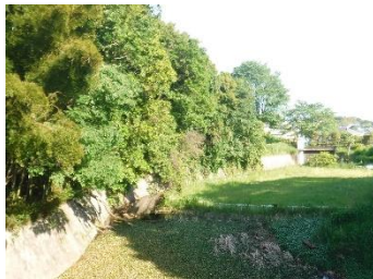
作業前の法面
