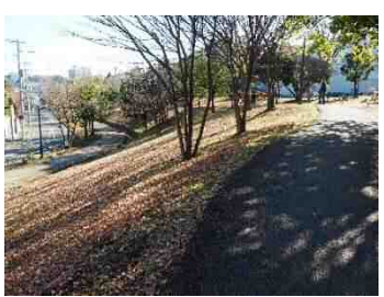
高低差による車道との分離
