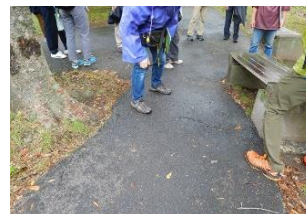
根上がりによるベンチの破損
