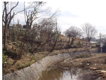
作業後の法面
