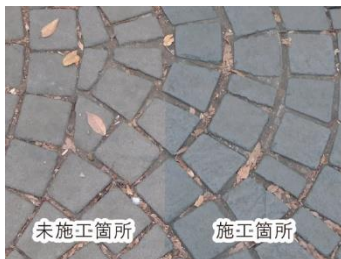
未施工箇所（左）と施工箇所（右）
