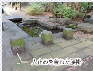
景観に馴染む白河石の土留兼ねベンチ 背後の排水溝の目隠しも兼ねている
