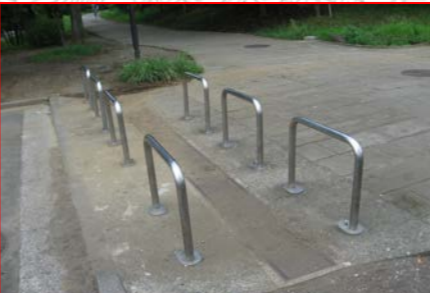
土の堆積 横断溝に土が堆積している
