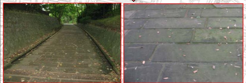
白河石舗装 (目地埋めあり) 日陰で湿度があるため苔が生えてすべりやすい。
