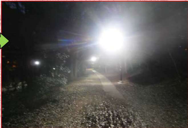
灯具のLED化 灯具をLEDに交換し、暗い場所の解消、省電力、長寿命化を図る。
