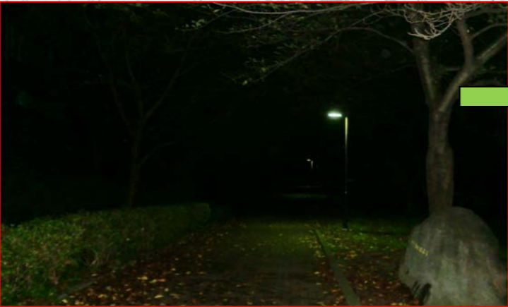
灯具の老朽化 照度が落ちて暗い場所がある。
