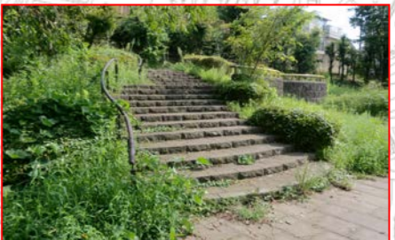
手すり、誘導用ブロック 階段の手すり、誘導用ブロックが基準に適合していない。
